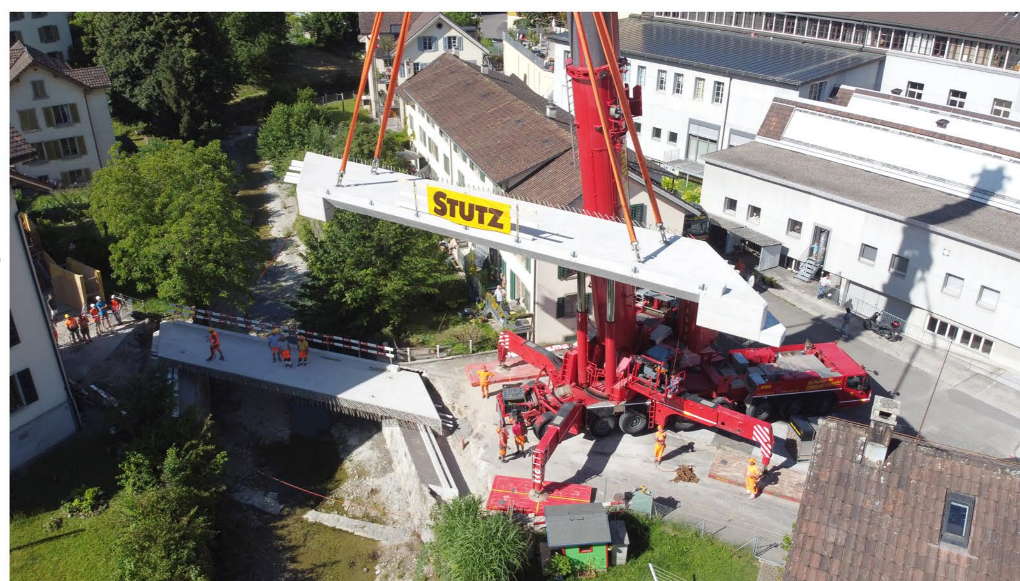
Einheben Brückenplatten in Wald
